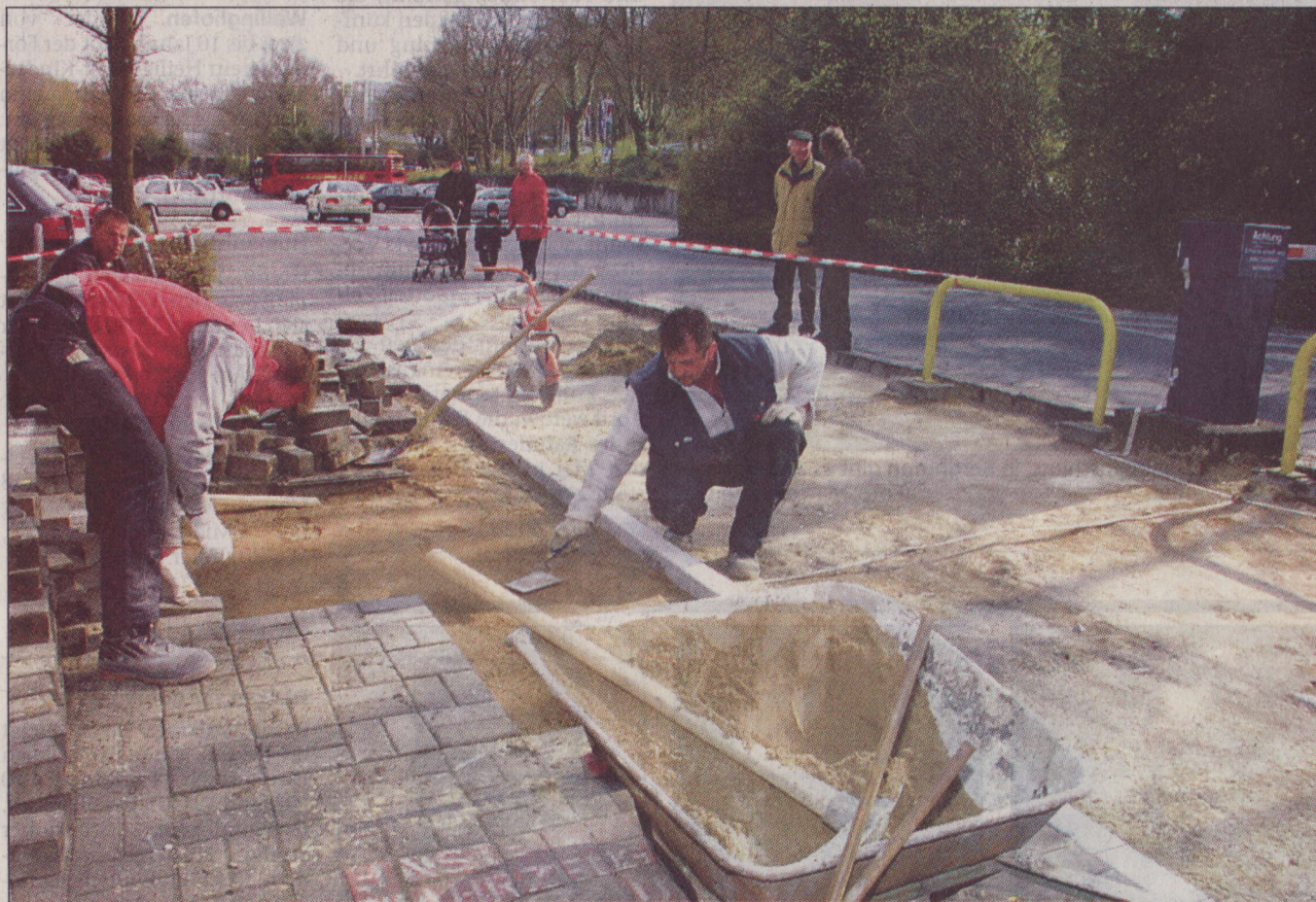
Steine pflastern die neue Einfahrt am Parkplatz Hohensyburg: Die Arbeiten im Auftrage von Betreiber SBB laufen auf Hochtouren. Acht Jahre mussten die Anlieger auf diesen Tag warten. (Foto: Bernd Hegert)
