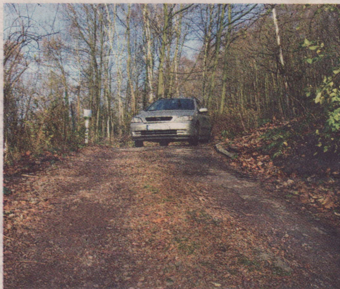
Ärger gibt es schon seit Jahren für die Anwohner am Klusenberg. Die Straßen und Wege sind in katastrophalem Zustand. RN-Foto: Klinke
